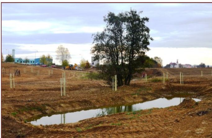
Suché poldry Bělotín — komplexní opatření k zachycení přívalových srážek na čtyřech přítocích Bělotínského potoka — pravostranných v lokalitách „Nad dálnicí“ (dvě nádrže o celkovém objemu 34900 m 3 ) a „U družstva“ 20900 m 3 , dále dvou levostranných — „Pod Stráží“ 36100 m 3 a „Úval“ 12400 m 3 . Realizováno v rámci tří projektů v letech 2015-16.
