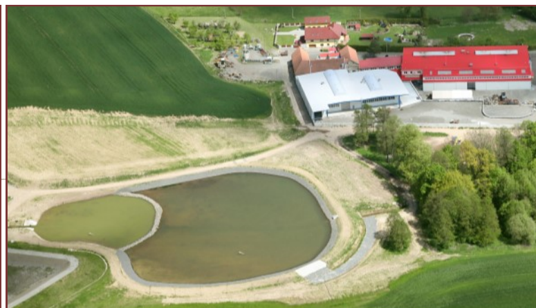
Projekt Protipovodňová opatření na katastru obce zahrnuje vodní nádrž s mokřadem „Revitalizace nad Tigemnou“ v k.ú. Bělotín na melioračním odpadu, který je významným přítokem Bělotínského potoka a soustavu tří průtočných nádrží „Lučinka“ na stejnojmenném potoce v k.ú. Lučice na Moravě. Ochranný objem nádrží je Tigma 11400 m 3 a 14600 m 3 Lučinka. Realizace proběhla v letech 2012-14.
