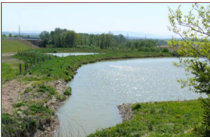
Laguny nad Bělotínem — soustava dvou průtočných nádrží na horním toku Bělotínského potoka byla realizována v letech 2003-4 v rámci projektu „Revitalizace toku Bělotínský II, obec Bělotín. Celkový zásobní objem obou nádrží činí 23140 m 3 .
